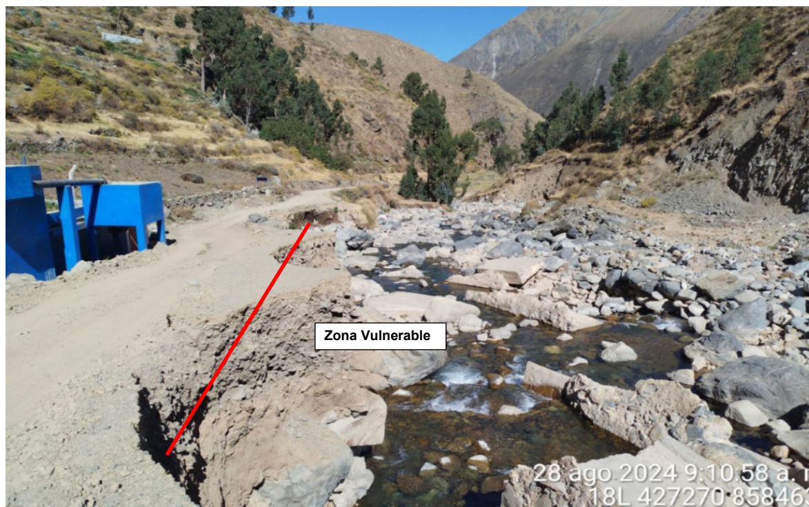
FIGURA N°02: SE OBSERVA LA MARGEN IZQUIERDA DEL RIO EL CUAL ES VULNERABLE ANTE UNA CREDIDA, POR DICHO LADO SE ENCUENTRA COMPLETAMENTE EROSIONADA.
